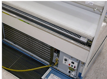
ショーケースへの接続例（サービスポートがある場合）
